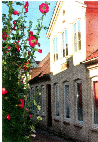
HausAltona an der Jürgenstraße.
