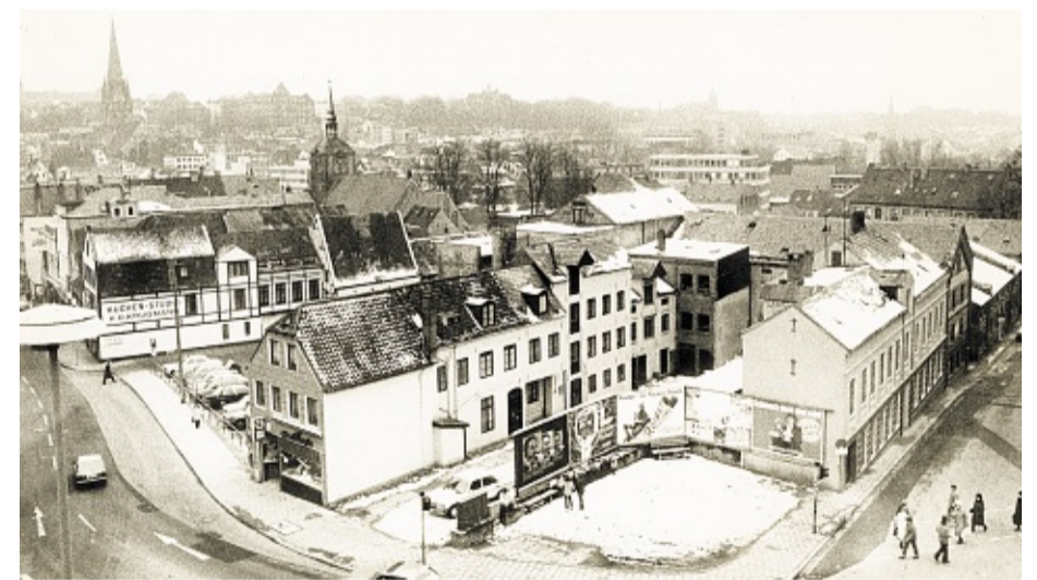
Die Ecke zwischen Johannisstraße und Angelburger Straße nahm die Harrisleer Getho-Bau für den Neubaukomplex 1981 ins Visier. SCHREIBER
