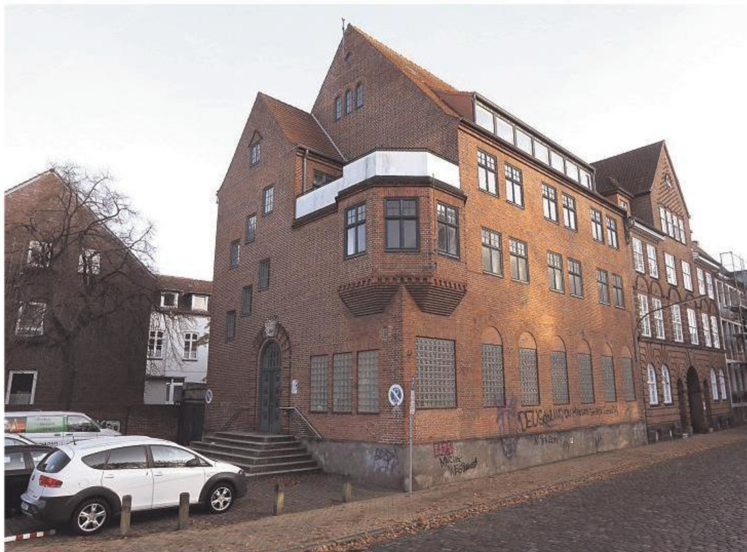
In dem Gebäude an der Ecke Karlstraße/Augustastraße befindet sich heute ein Umspannwerk der Stadtwerke MICHAEL STAUDT (3)
