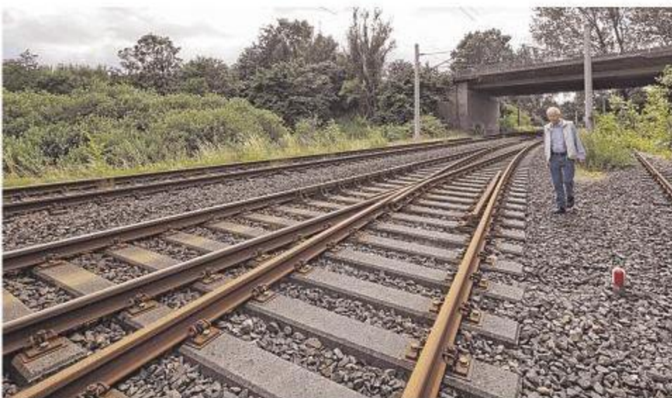
Weichenstellung für die Zukunft: Kurt Neumann, Vorsitzender der Bahn-AG, an der Weiche zum Hafen, die die Bahn demontieren will. Für die Option „Bahnhof Zob“ müsste sie dann reaktiviert werden. MARCUS DEWANGER
